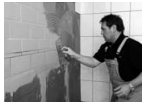
Die neuen Fliesen werden mit PCI Nanolight® verlegt ...
