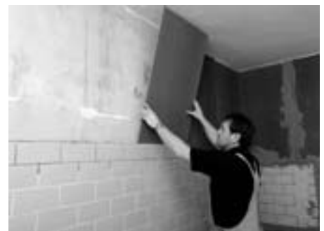
Ausgleichen des Fliesenspiegels im Überkopfbereich.
