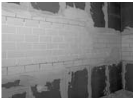
Die Übergänge werden beigespachtelt.
