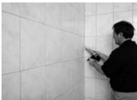
Dauerelastische Verfugung mit PCI Silcofug® E.
