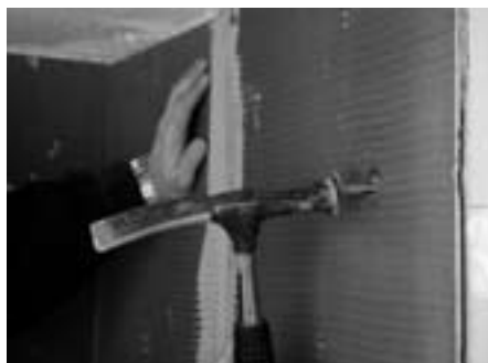
Die PCI Pecidur® Elemente werden mit- tels Schlagdübeln befestigt.
