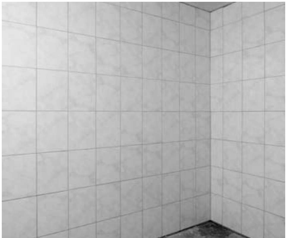
Voilà – die fertige Wandfläche.
