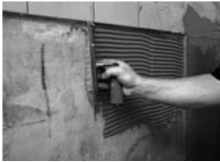
Der Kleber wird unterhalb des Fliesen- spiegels aufgezogen.
