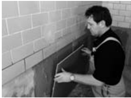
Die PCI Pecidur® Elemente werden auf den frischen Kleber angesetzt ...
