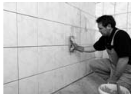
... und verfugt mit der staub- und emissionsarmen PCI Flexflug® extra.
