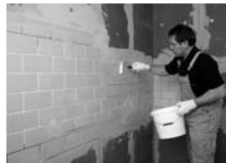
Untergrundvorbereitung: Der alte Fliesen- belag wird mit PCI Gisogrund® 303 grundiert.
